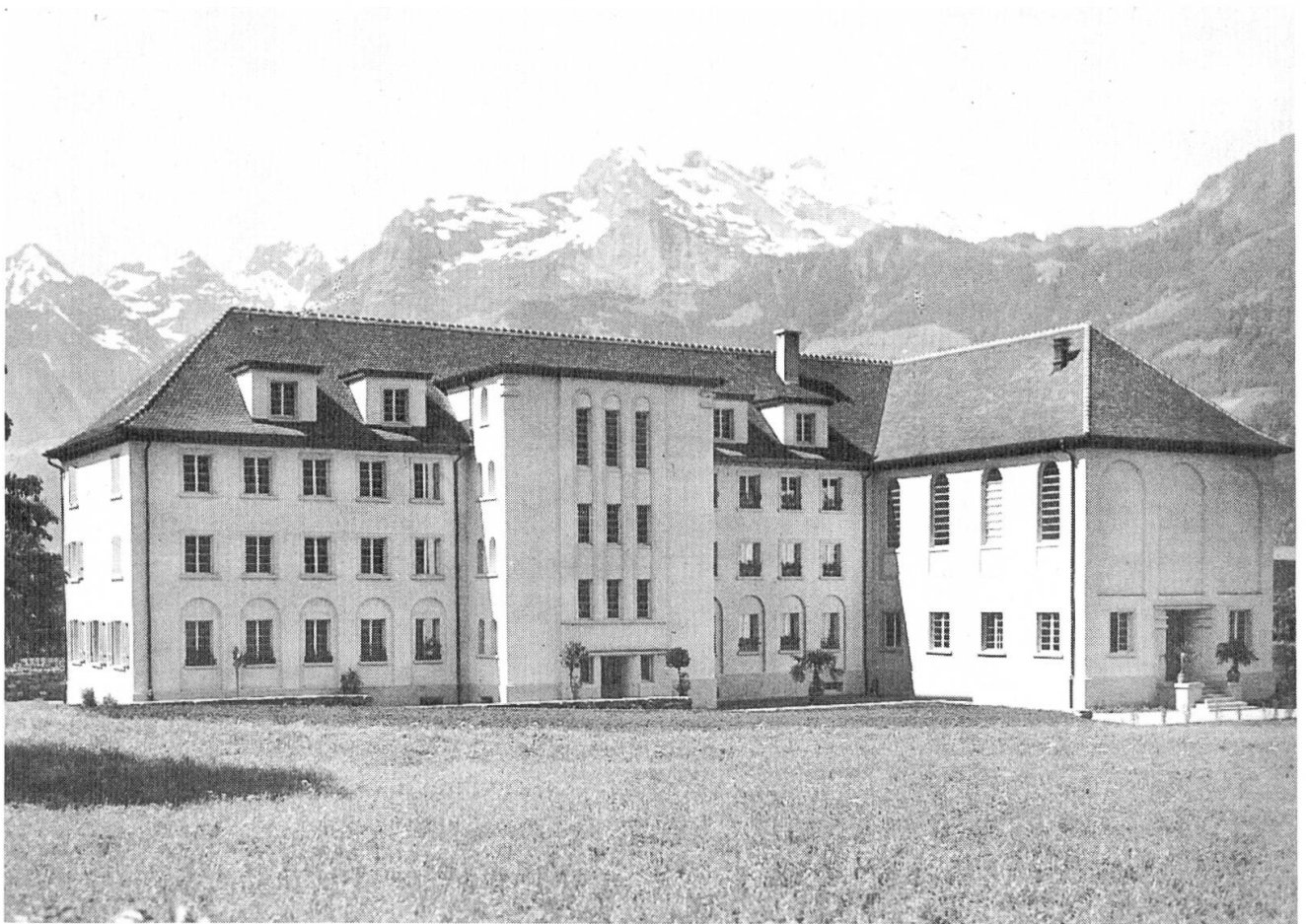
Das 1935/36 gebaute Professorenheim beim Kollegium Karl Borromäus in Altdorf.
