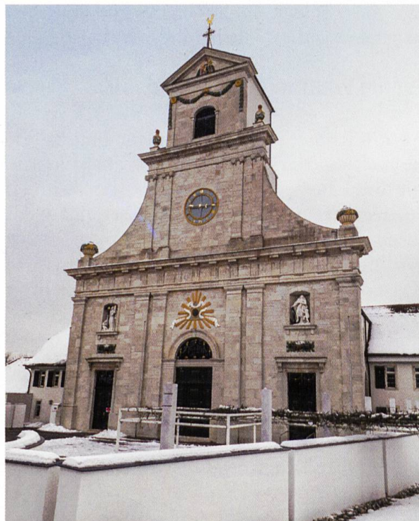
Frisch renovierte Fassade der Klosterkirche.
