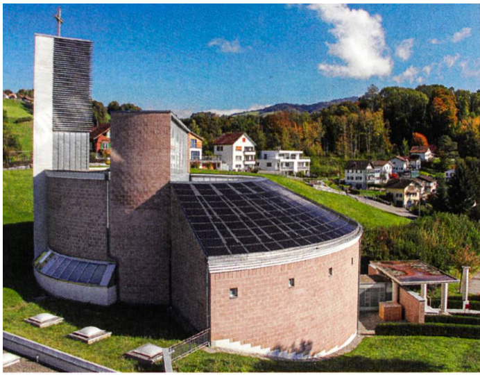
Abteikirche mit Solardach.
