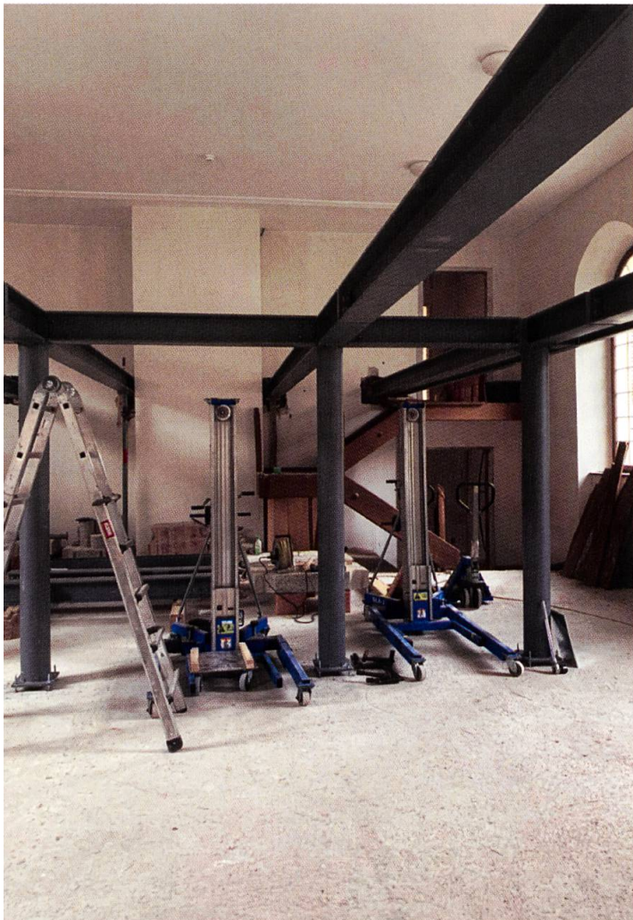
Die Stahlträger für die Zwischenböden.
