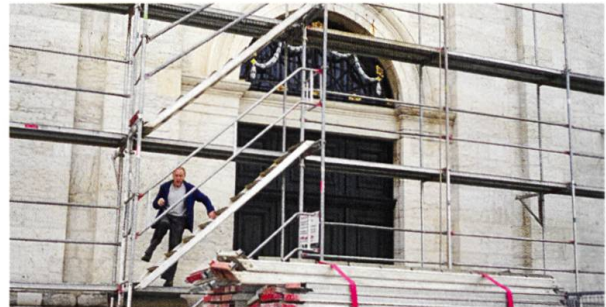
Guido Marquis im Einsatz: Restaurierung der Fassade, 2020.
