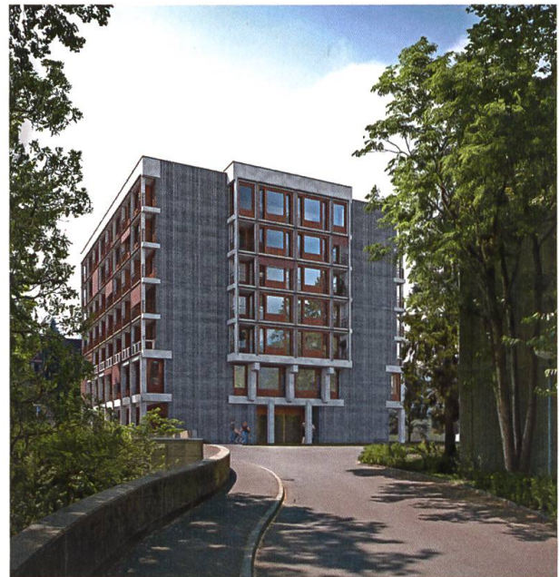
Kloster Ingenbohl: Zugang Nordseite, neue Eingangssituation.
