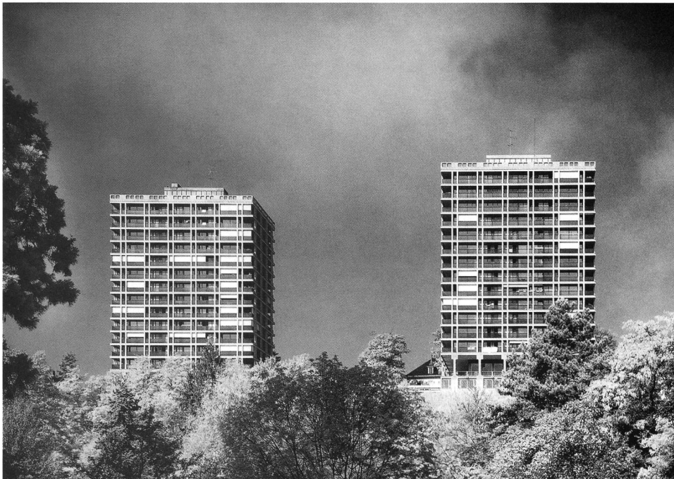
Jean-Marc Lamunière, les Tours de Lancy (1960-1964) à Genève, vue des deux tours construites. Photo Jean Pierre Flury. Doc. archives Jean-Marc Lamunière.
