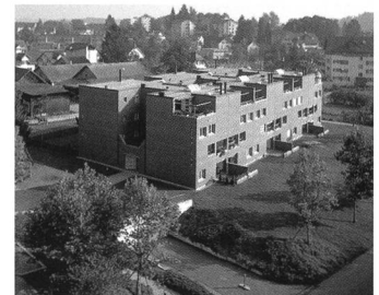
Michel Roux-Spitz, immeuble rue Guynemer à Paris, 1925.
