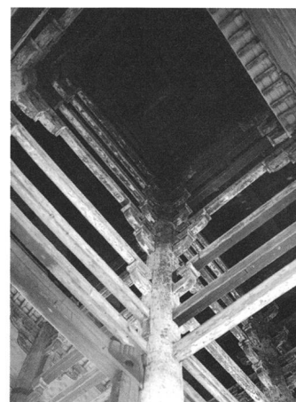
Vue intérieure des piliers de la grande porte sud Nandaimon réalisée en 1199 par Chôgen au temple de Tôdai-ji à Nara, in J. S. Cluzel, Architecture éternelle du Japon, 2008, p. 62.
