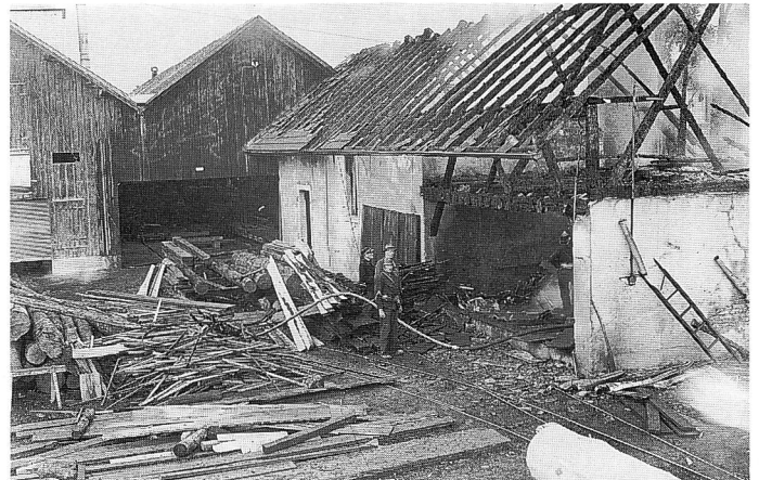
Brand der Trocknungsanlage der Sägerei Vogt, 1944.
