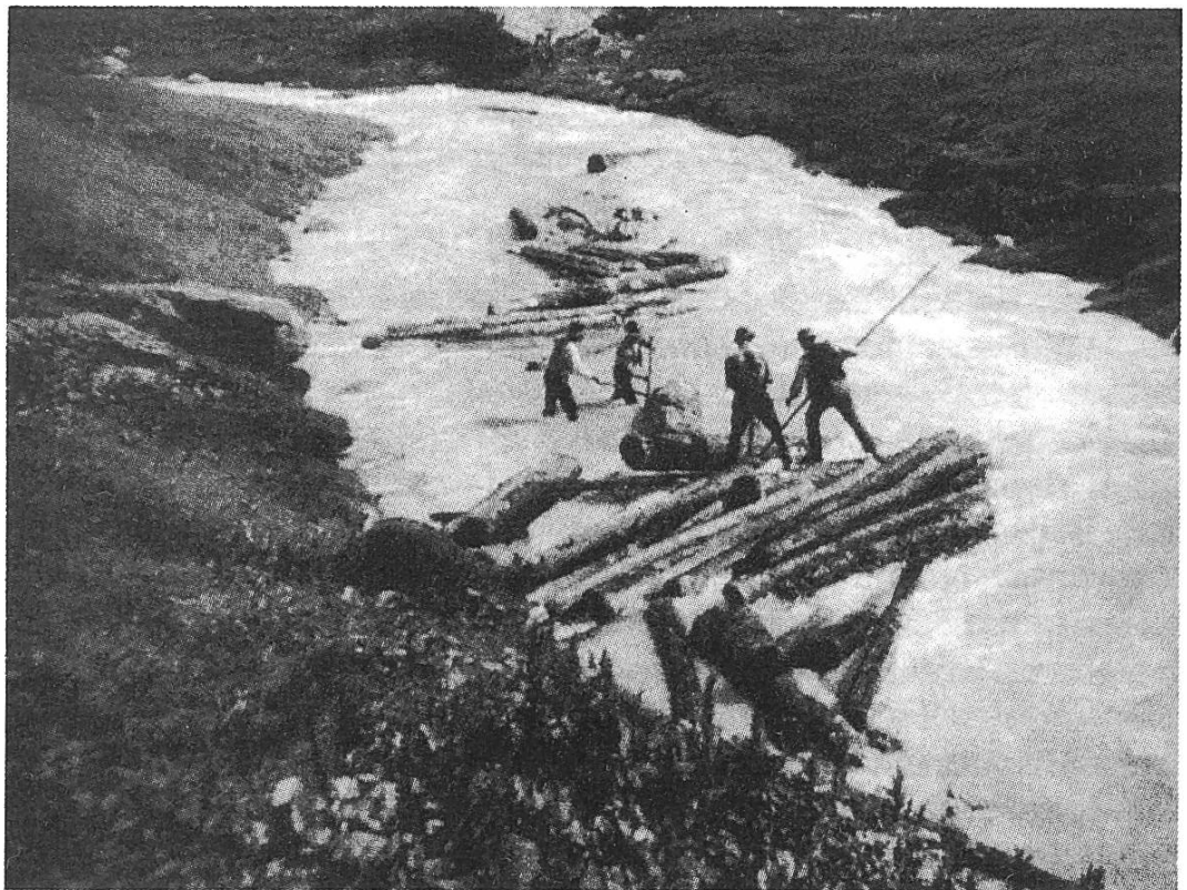
Holztransport auf dem Wasser. Aus: Der Wald im Kanton Schwyz, S. 19.
