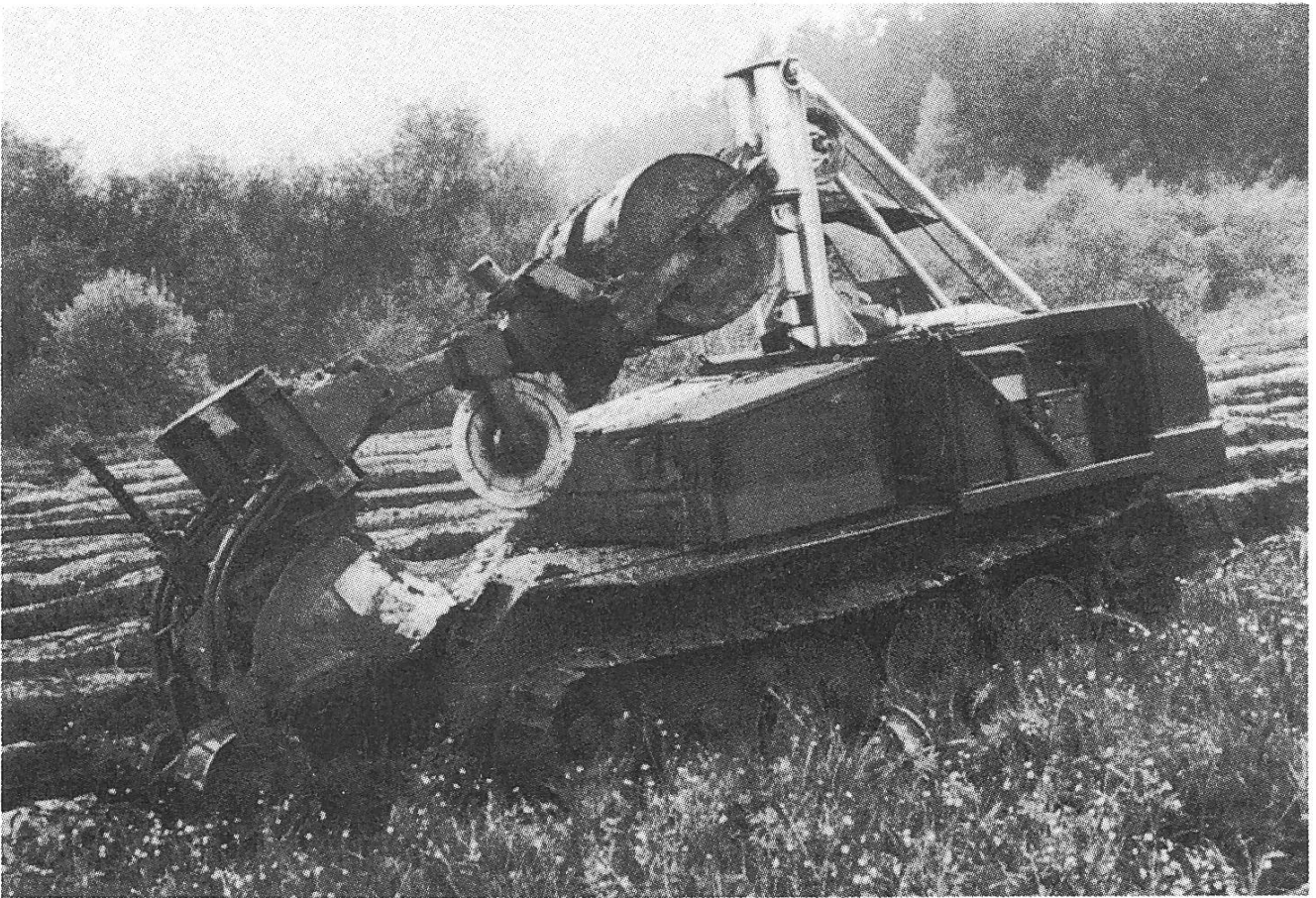
Motormuli und Entwässerungspflug. Noch zu Schwyters Zeiten wurden die Entwässerungsgräben wohl von Hand ausgehoben. Aus: Der Schwyzer Wald, S. 50.
