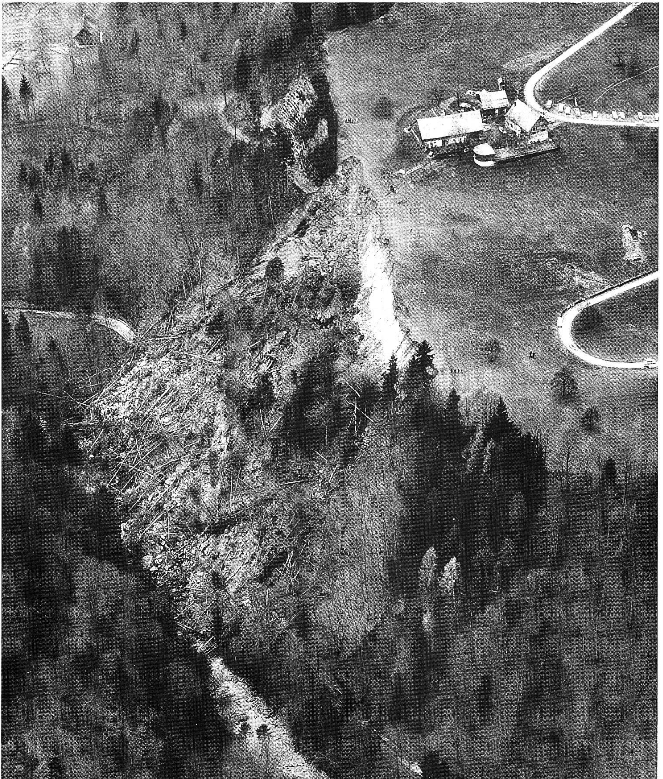
Bergsturz beim Gusöteli 1969. Die Flugaufnahme Comet zeigt das erschreckende Ausmass. (Akten BAL)
