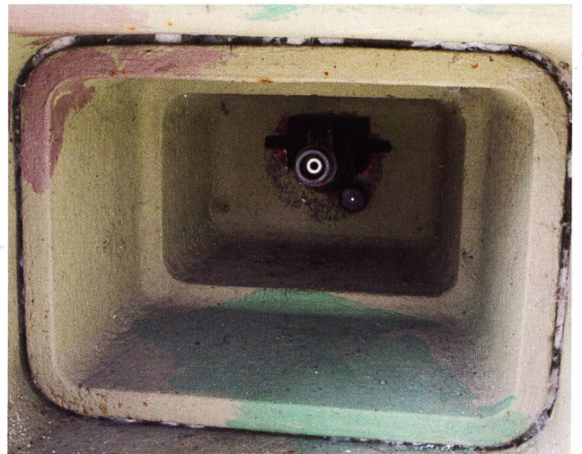
Abb. 45 Lmg-Scharte des Standes E von aussen. Unten rechts der Aufsatz zur Stabilisierung der Waffe.
