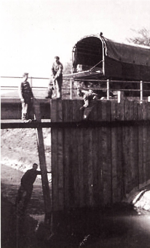
Abb. 21 Nadelwehr in der Linthebene 24
