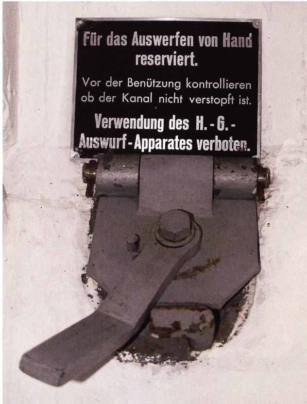
Abb. 48 Deckel der HG-Auswurföffnung im Stand E
