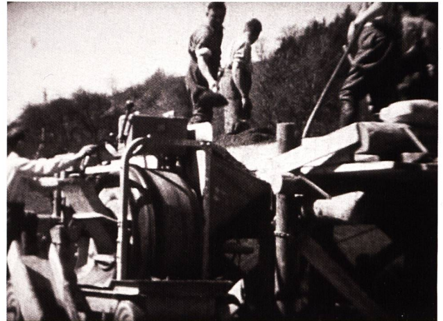
Abb. 33 Ein baugleicher Betonmischer kam auf der Baustelle für das Werk Grynau zum Einsatz. 19
