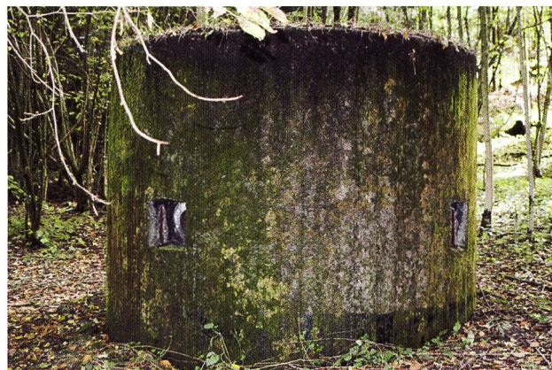
Abb. 5 Die Auspuffanlage befindet sich rund 30 Meter nordöstlich des Bk-Standes 19.
