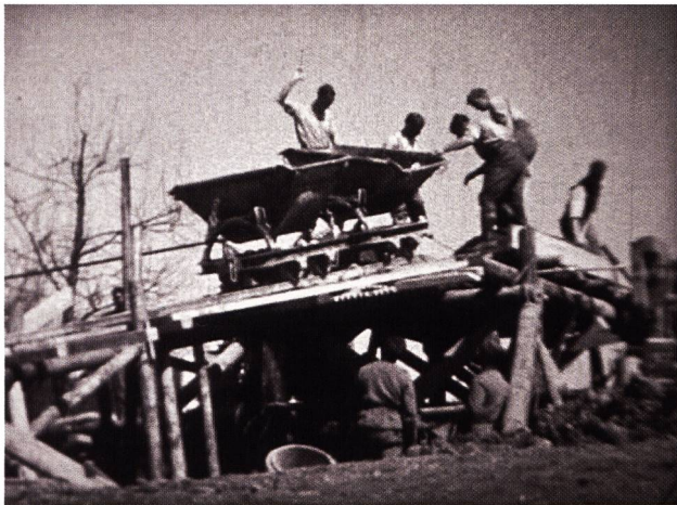
Abb. 32 Gemäss August Bleiker sah die Rampenkonstruktion mit Wellenbock beim Eingang zur Baustelle genauso aus wie diese aus dem Jahr 1940 auf dem Buchberg bei Tuggen. 18
