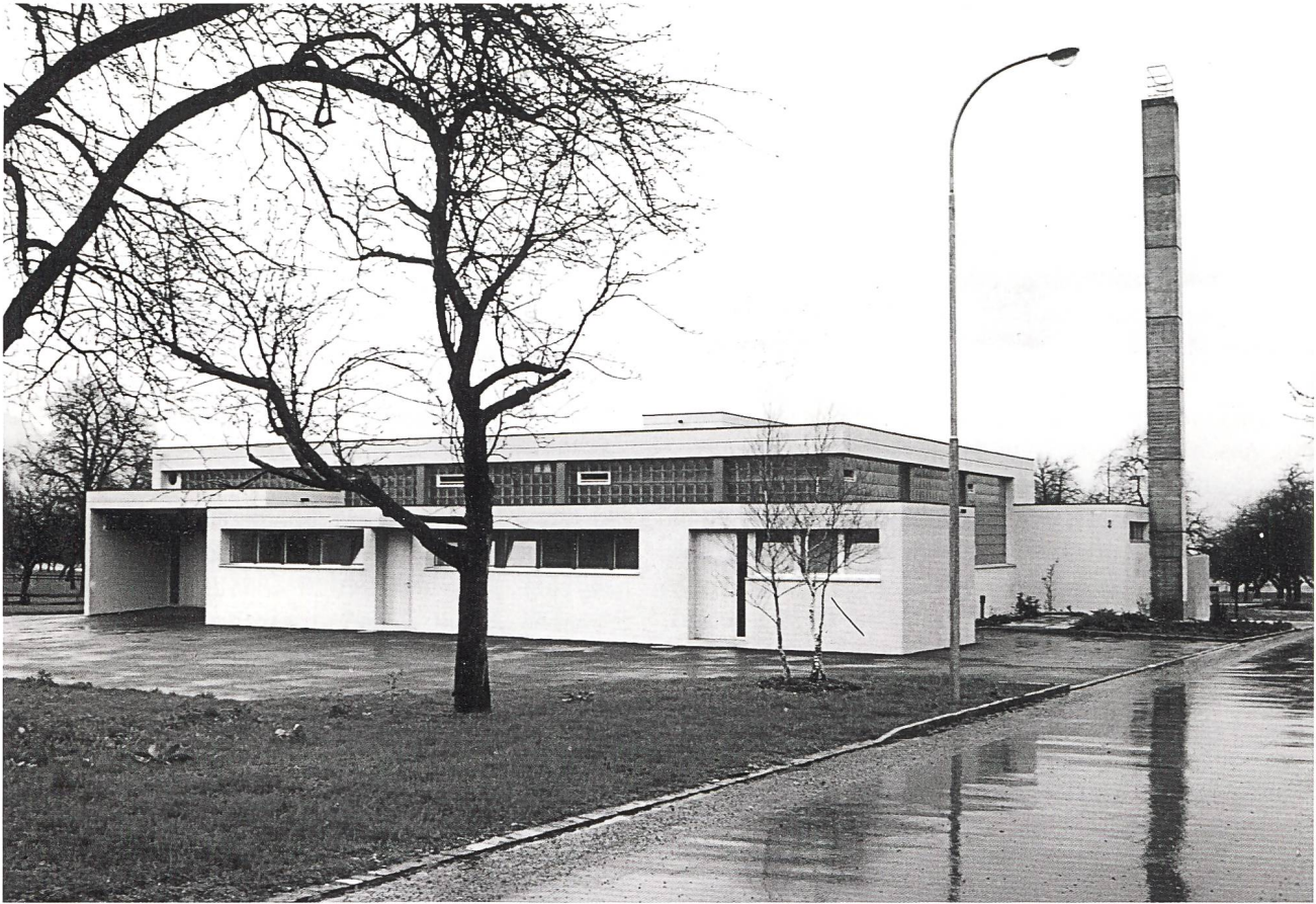
Schlachthaus Altstätten SG, Neubau 1964, im Vordergrund die Auslieferung sowie Räume für Büro Personal, im Hintergrund der Schlacht- und Kühltrakt, rechts aussen die Kadaververbrennung.
