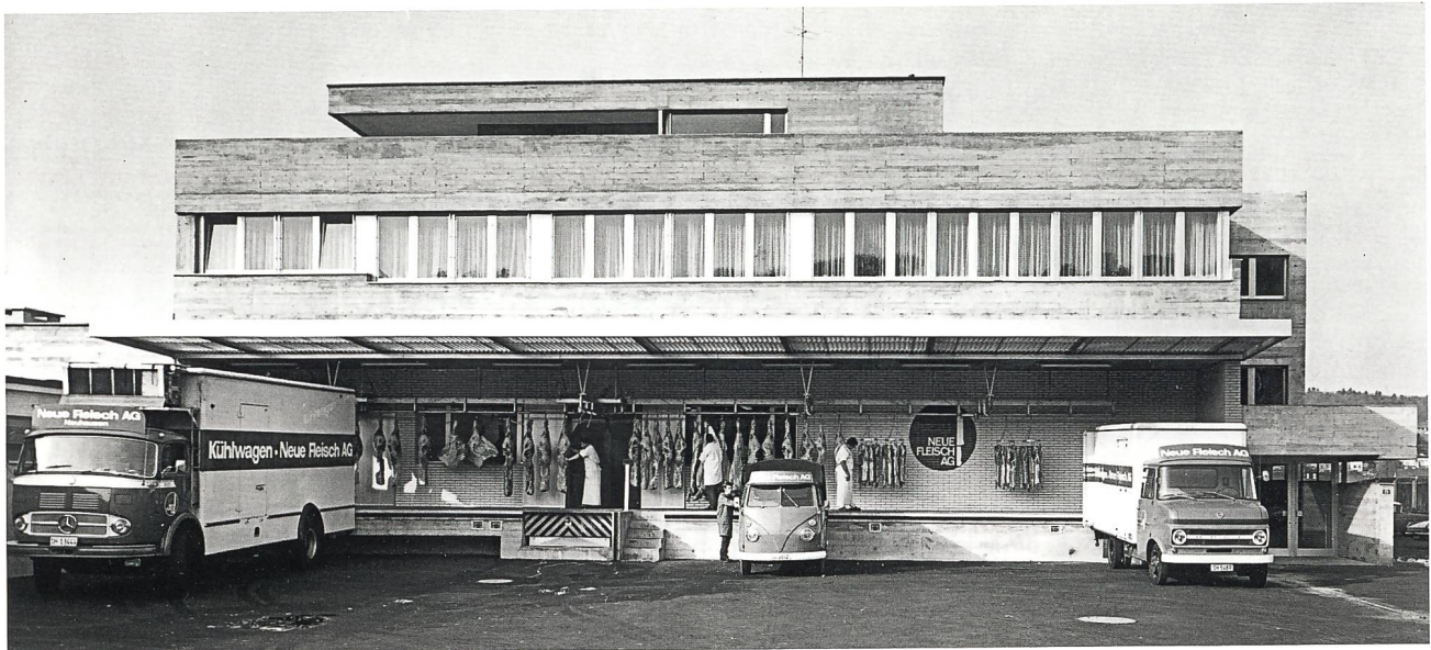
Neue Fleisch AG (NEFAG), Schaffhausen, Neubau 1968 mit Auslieferung, darüber die Büro- und Sozialräume mit der Attikawohnung. Dahinter liegen Kühl- und Produktionsräume, im Untergeschoss Gefrier- und Reiferäume und die Energiezentrale.
