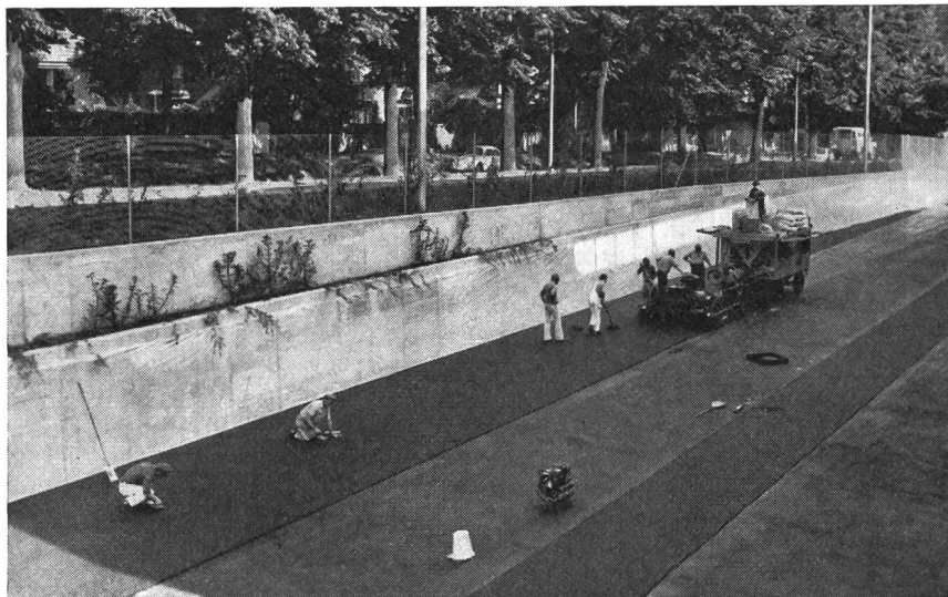
Recaflex: Spitzenbelag für Mehrzweck-, Spiel- und Sportanlagen (Kunststoffgebundenes Material auf Polyurethan-Basis)
