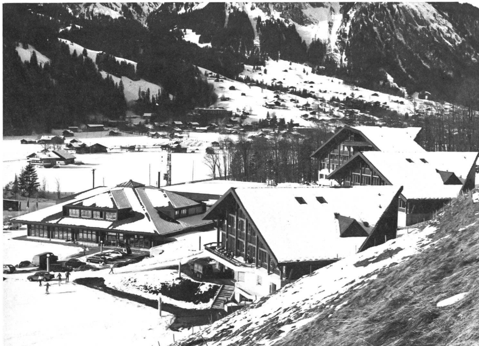
Das KUSPO Lenk mit den drei «Camps», dem Zentralgebäude und der im Bau befindlichen Dreifach-Turnhalle (verdeckt durch das Zentralgebäude). Im Hintergrund der Kurort Lenk.
