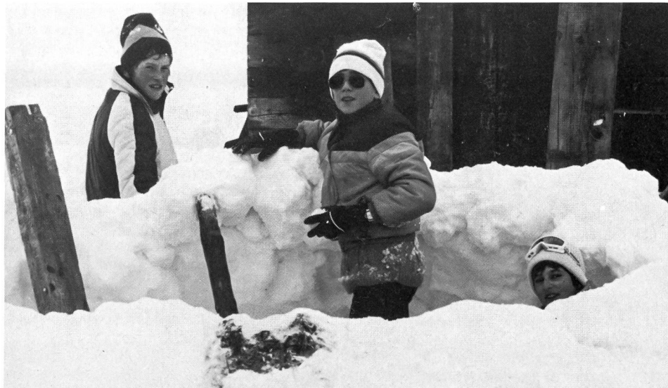
Pfähle stützen die Schneeböcke ab bis zum Anfrieren.
