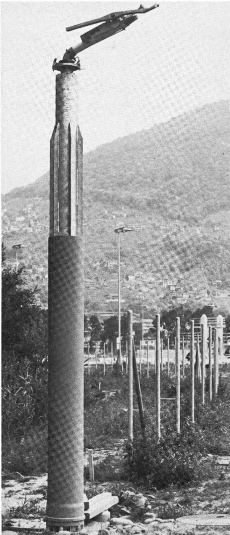
Anstelle einer Berieselungsanlage werden die Sport- und Rasenfelder mit weitreichenden Wasserfontänen bewässert, welche direkt aus dem Grundwasser gespiesen werden.
