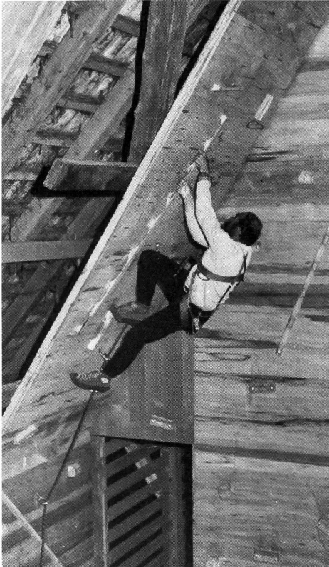
Ausnutzung der Dachschräge als Überhang (Kletterwand Ueli Werren, Langnau).
