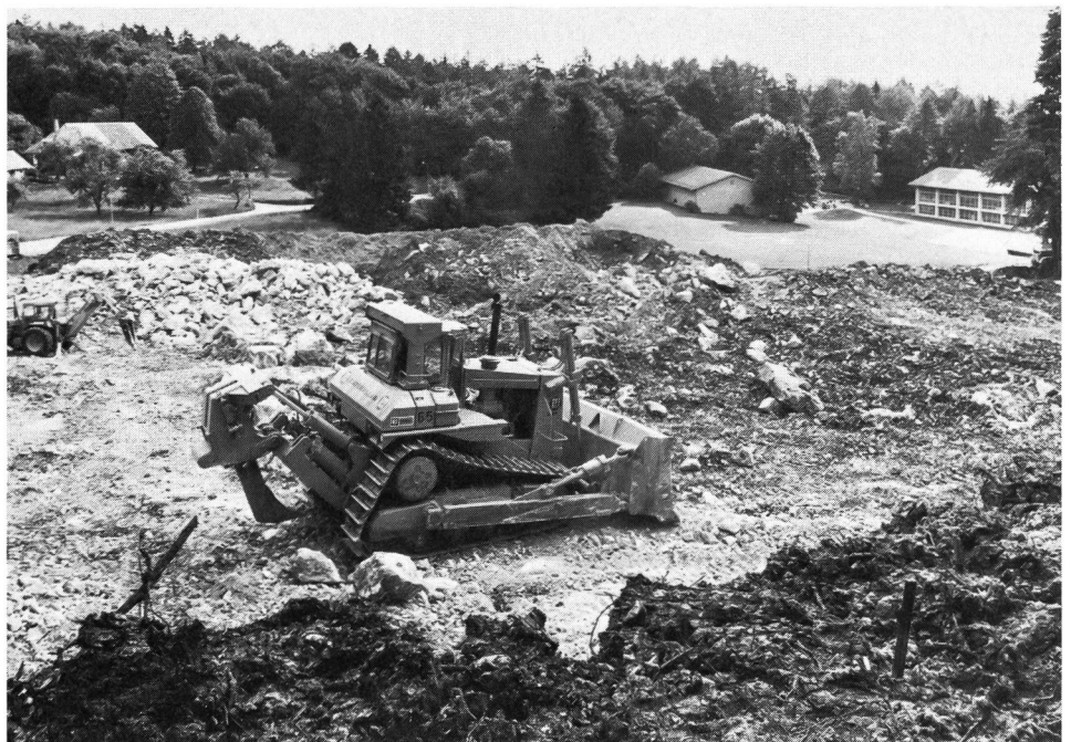
Im Reich der Bulldozer: Radikale Veränderung einer Landschaft selbst im ästhetisch geglückten Sportstättenbau, hier am Beispiel der Baugrube für die Jubiläumsturnhalle in Magglingen. Doch die Halle selbst heilte alle Wunden durch die geschlossene Einfügung in die Scharte.
