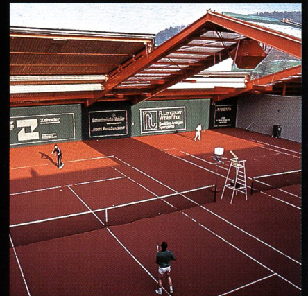
AGOB-Schiebedachhallen Tenniscenter Grütze Winterthur
