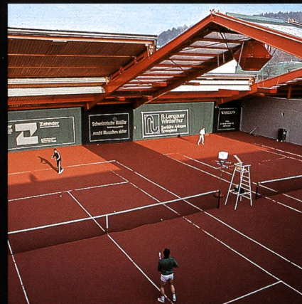
AGOB-Schiebedachhallen Tenniscenter Grütze Winterthur
