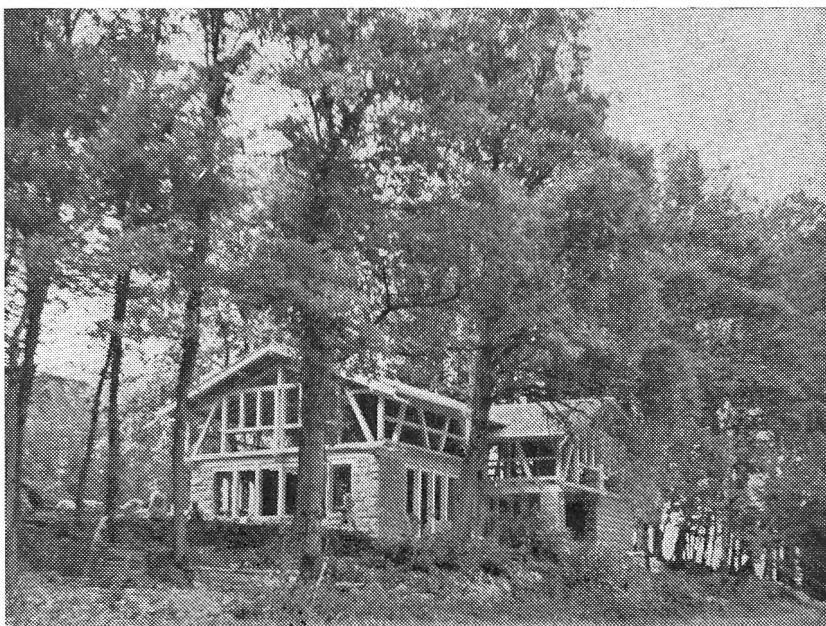
Première réalisation : Le pavillon.
