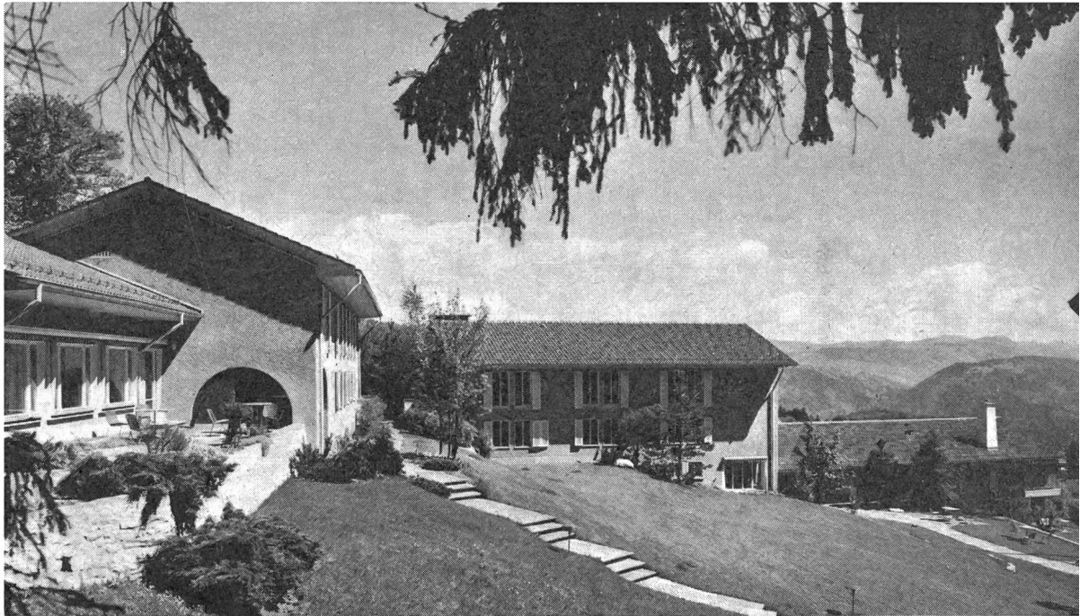
SLL-Gebäude Pavillon de l'ANEP Padiglioni dell'ANEF
