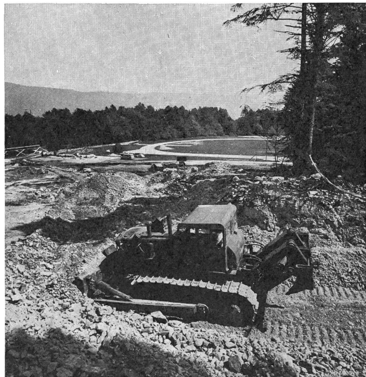
Les fouilles en mai 1974. Le chantier était encore un amas de décombres.
