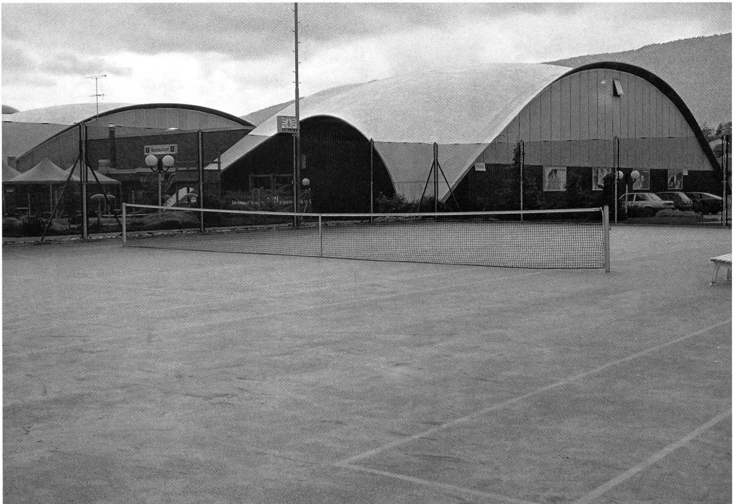
Gazon synthétique sablé du CIS de Marin (NE).
