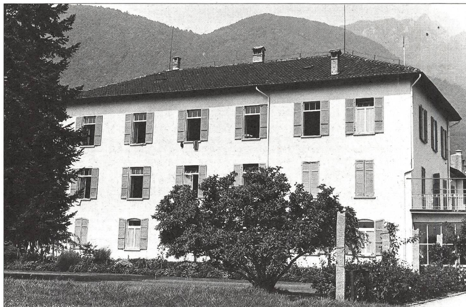
Le bâtiment de logement.
