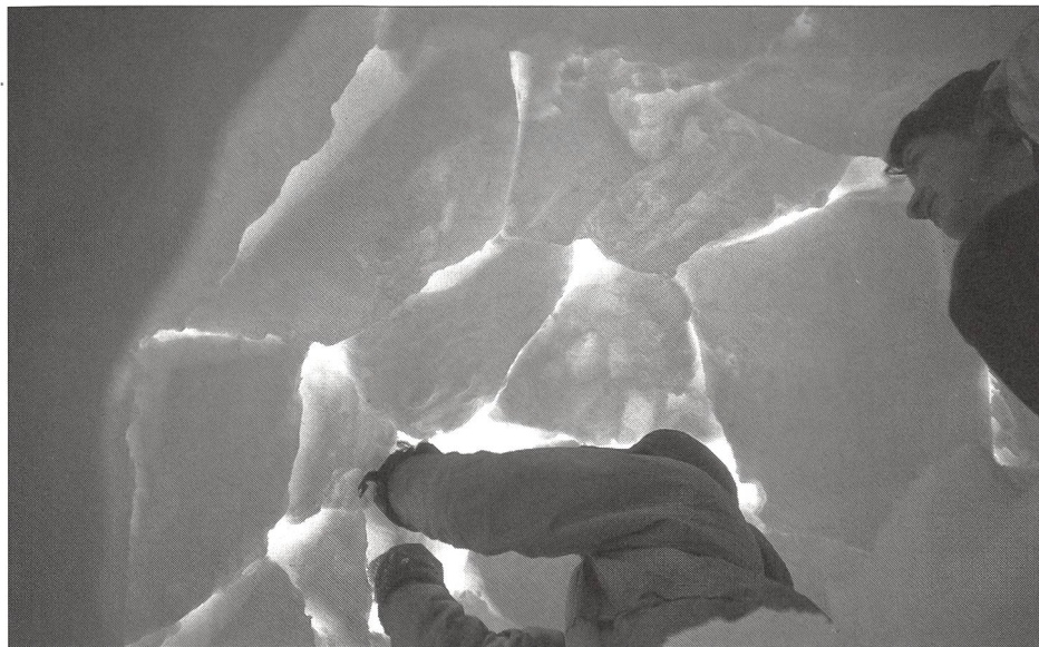
Les derniers blocs sont posés depuis l'intérieur.
