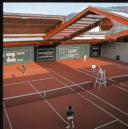
Halle à toit ouvrant AGOB Centre de tennis Grüze Winterthur
