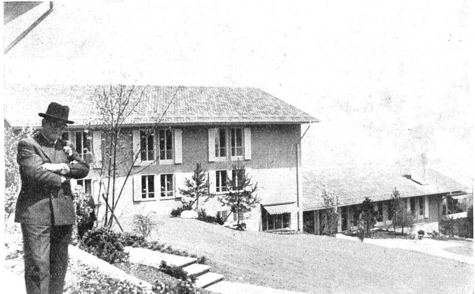
I padiglioni di abitazione di mezzo e inferiore visti dall'interno. Nel primo sono a disposizione 6 camere a 4 letti e due camere a due letti, nel secondo 3 camere a 3
