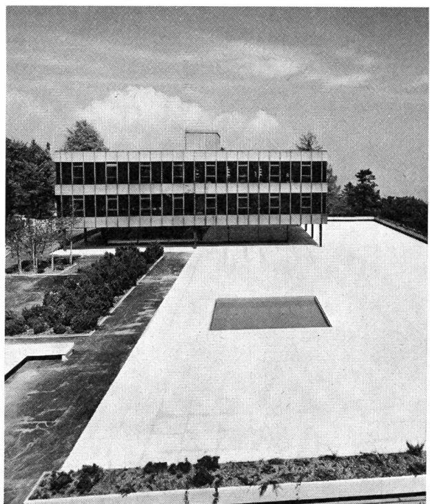
Sguardo dal vecchio edificio: terrazza con blocco superiore
