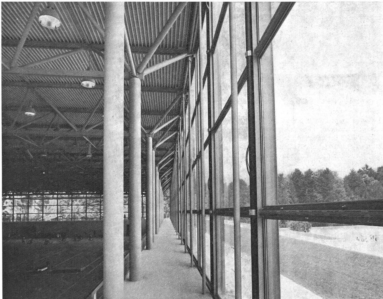
Galleria con le travi portanti d'acciaio, i cavi di tensione nascosti nella facciata.
