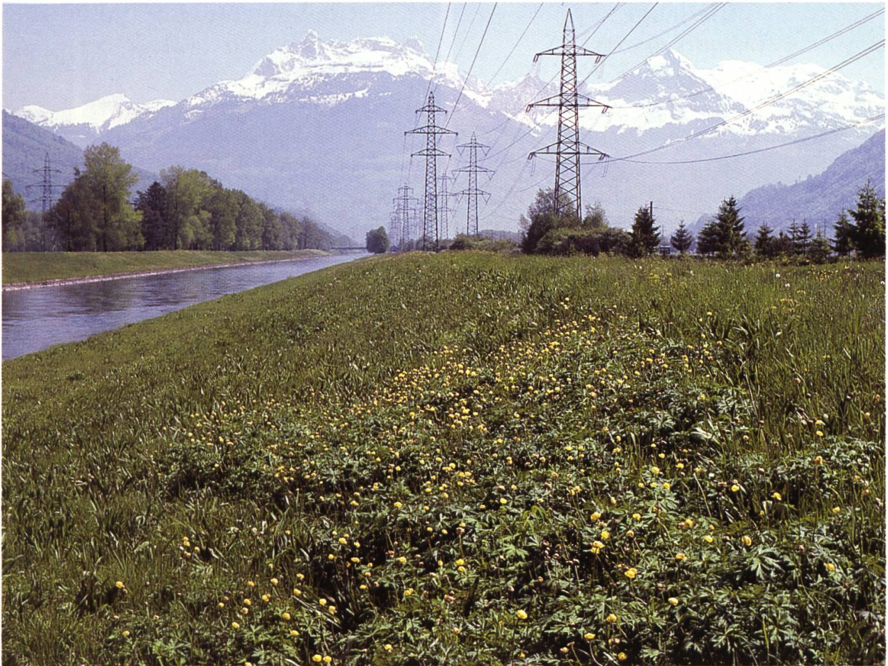
Abb. 2: Der Damm am Linthkanal im Mai.
