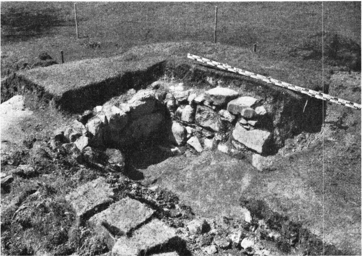
Aufgehende Innenmauern mit Mörtelgußboden. — Oben: West- und Nordwest- mauer, dahinter Rampe. Fotoplan Pos. 29. — Unten: Innere Südwestecke mit Mörtel- boden. Fotoplan Pos. 24.
