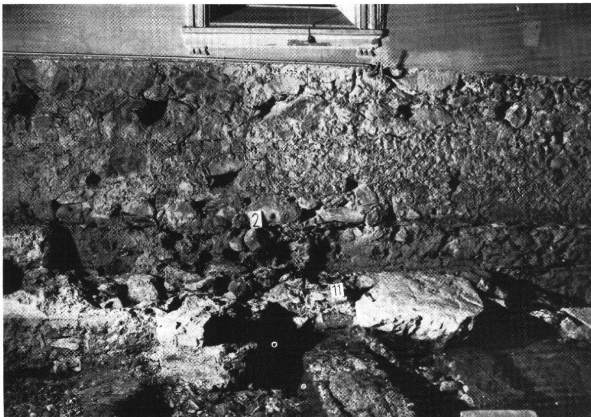
Ansicht an die heutige Südmauer (Nr. 2), die im unteren Teil gegen die ältere Südmauer (Nr. 11) von 1501 gemauert war.
