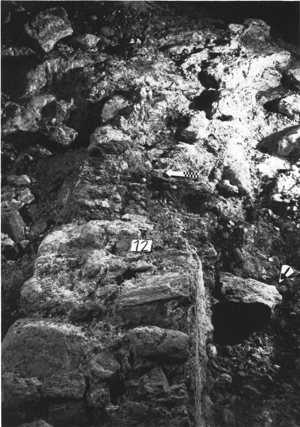
Schiffnordmauer «C» (Nr. 12) nach Entfernen der Aufmauerung des Polygonalchores «E» und des Triumphbogeneinzuges: Die untersten 1–2 Steinlagen der Nordmauer «C» weisen im Bereich des Chores die gleiche Außenflucht auf wie die Schiffnordmauer, innen ist das Fundament um eine Steinbreite eingezogen (Pfeil).
