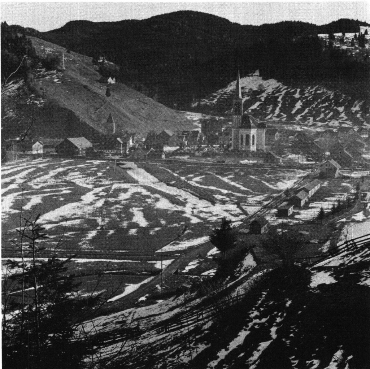
Letzi Altmatt/Rothenthurm. Blick vom Hang des Morgartenberges gegen Rothenthurm. Der Letzi Graben zeichnet sich im Gelände als breites Schneeband ab. Aufnahme Josef Keßler, November 1957
