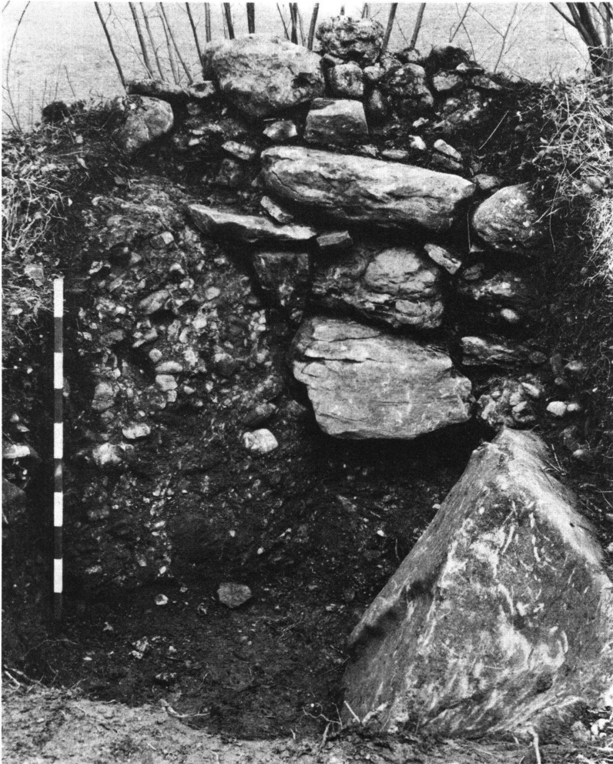
Letzi Arth/Sonnenberg oberer Schnitt. Sicht von Osten (Verteidigerseite) an die freigelegten Mauerfundamente. Auffällig ist, daß Bergsturzmaterial, z.B. der Nagelfluhbrocken links, in die Konstruktion einbezogen worden ist.
