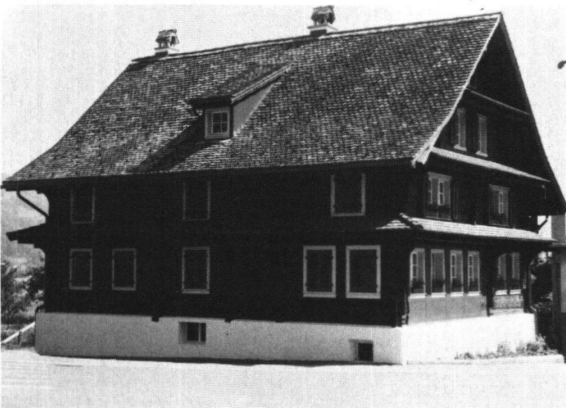
Lauerz, Haus Niedermatt: Der von der Pfarrkirche dominierte Dorfplatz von Lauerz ist von einigen Holzbauten verschiedener Prägung umgeben. Zum älteren Baubestand gehört das 1766 datierte Wohnhaus Niedermatt. Typisch für den beginnenden Klassizismus ist das einseitige Fehlen der Laube, an deren Stelle das Klebedach durchgezogen wird.
