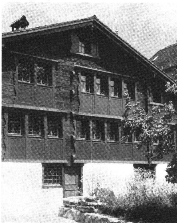
Schwyz, Haus Degen: Ansicht des ältesten Bauteils mit gotischen Reihenfenstern. Die Ziehladenverkleidungen konnten anhand des Befundes rekonstruiert werden. Bis tief ins 19. Jahrhundert waren in Schwyz noch verschiedene ähnliche «Tätschdachhäuser» vorhanden, die sukzessive durch Steinbauten ersetzt wurden.
