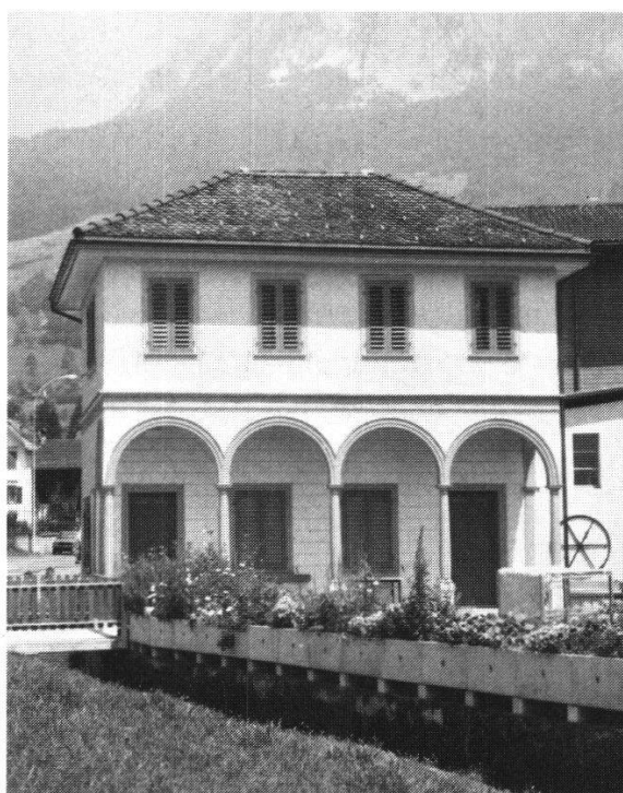
Schwyz, Stampf: Frühen Industrie- und Gewerbebauten wird in jüngster Zeit vermehrt Beachtung geschenkt. Für das 19. Jahrhundert ist die strenge Symmetrie der Fassaden sowie der geringe Neigungswinkel des Walmdaches typisch.
