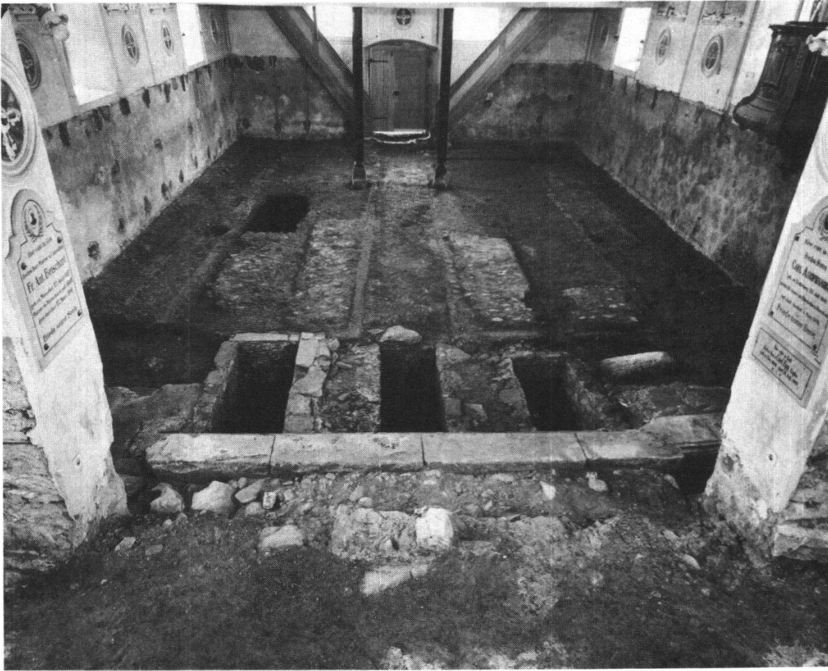
Abbildung 27 Jüngstes Grabungsniveau im Langhaus; Ansicht gegen Westen. Erkennbar sind Balkenlager einer späteren Fußbodenkonstruktion (wahrscheinlich aus dem Jahr 1659).
