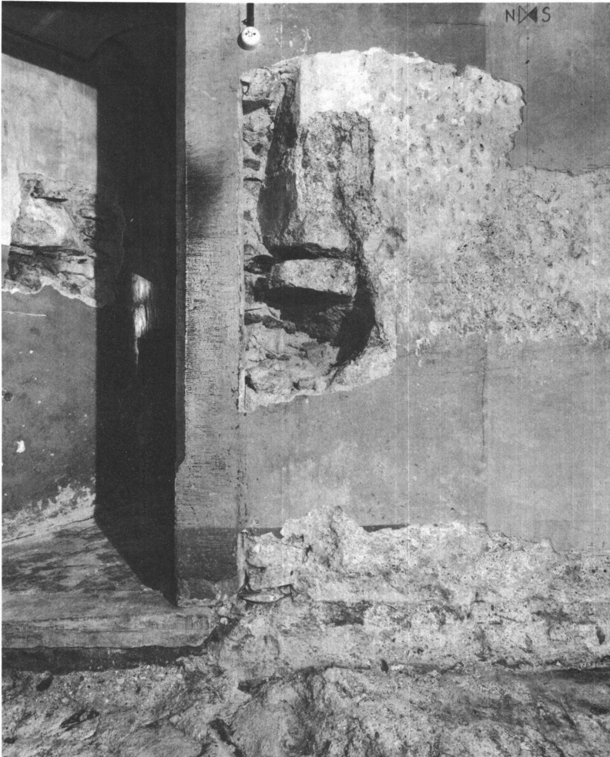
Abbildung 15 Anlage II, Ansicht der Altarwand mit den Resten eines Fensters. Links davon die Türe zur Sakristei von 1796.
