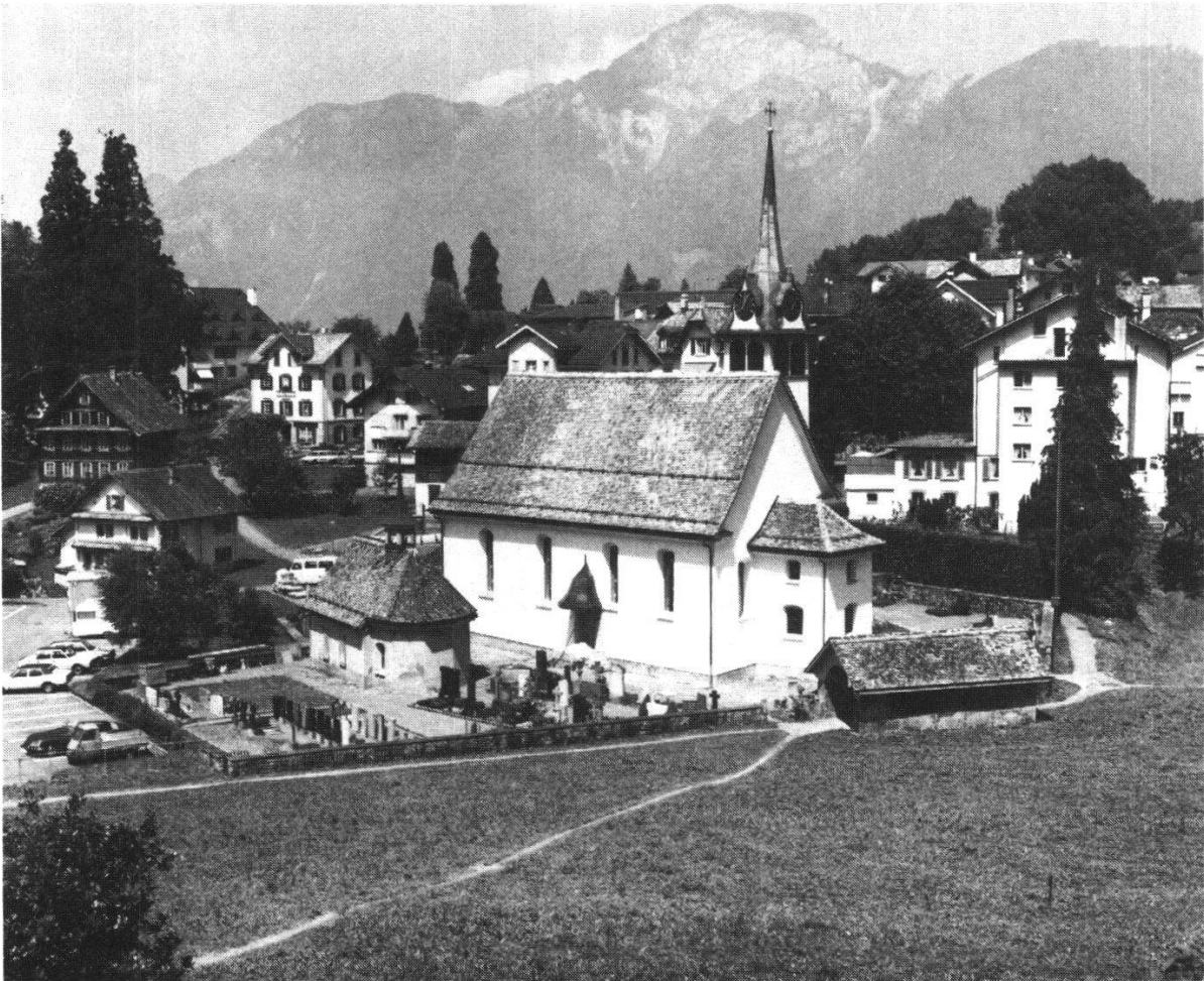
Abbildung 1 Pfarrkirche Morschach von Südosten gesehen (Aufnahme Frühjahr 1986).
