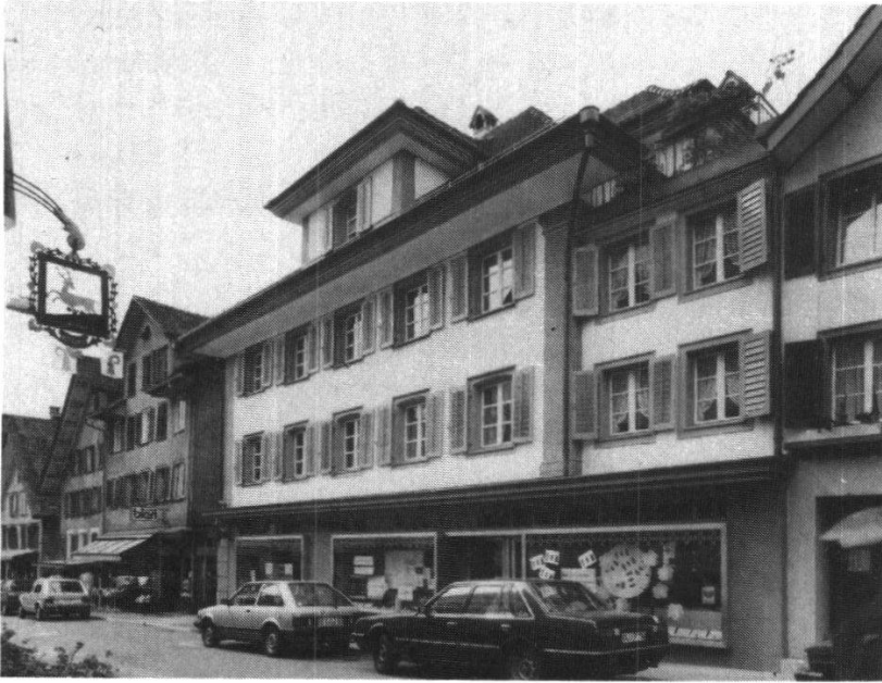
Küßnacht; Haus zur Taube, Außenansicht nach der Wiederherstellung der ursprünglichen Fassaden-dekoration
