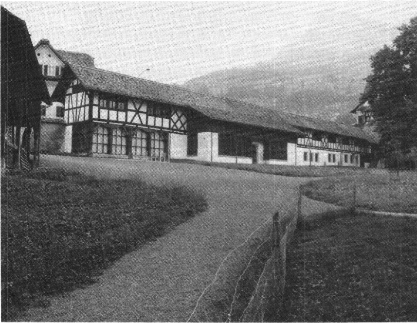
Schwyz; Ökonomiegebäude Ital Reding-Haus nach der Restaurierung
