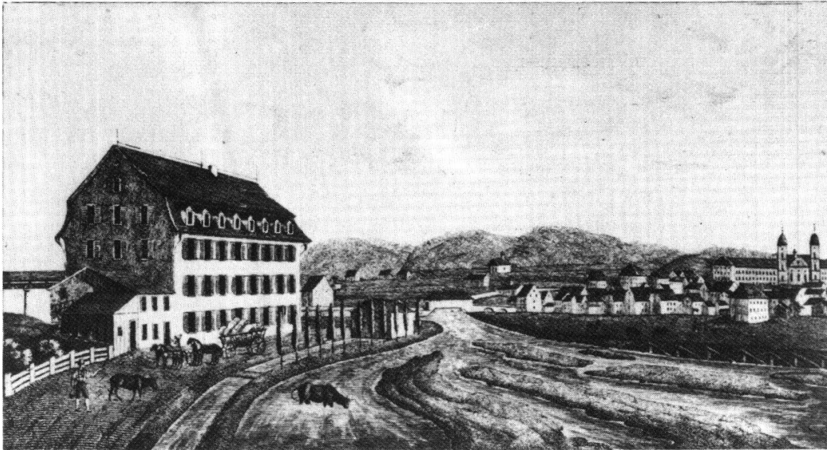
Die Spinnerei Schöngarn, welche Säckelmeister Heinrich Wyss um 1820 erbaute und die das Wasser für den Werkbetrieb ab der Grotzenmühle erhielt. Man beachte Haupt- und Nebenstrom der Alp. (Foto: P. Damian Rutishauser)
