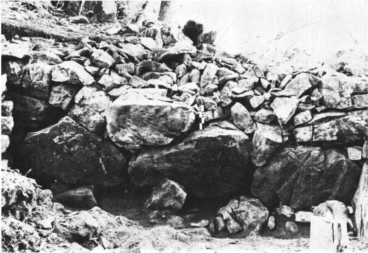
Illgau/Balmis 1987, Gebäude 1, Innenmantel der Nordmauer
