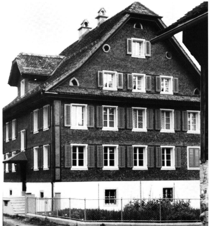
Abbildung 14 Arth, Haus Ehrli. Hauptfront nach der Restaurierung.
