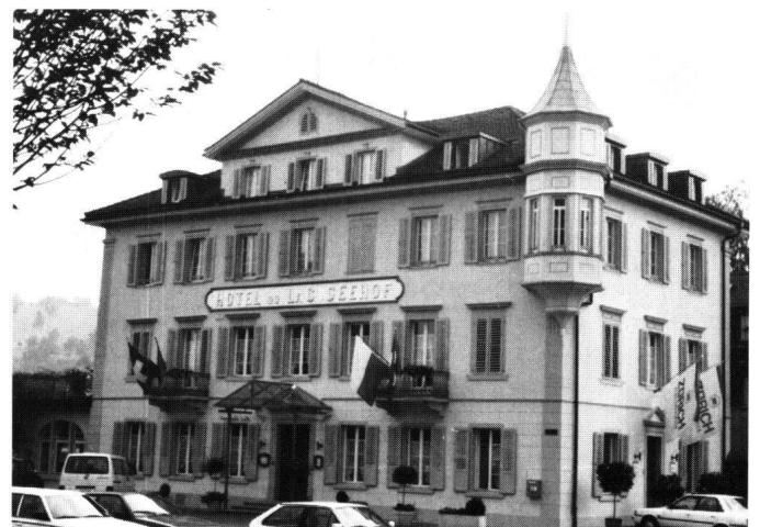
Abbildung 40 Küssnacht, Seehof. Die Hauptfront nach der Restaurierung.
