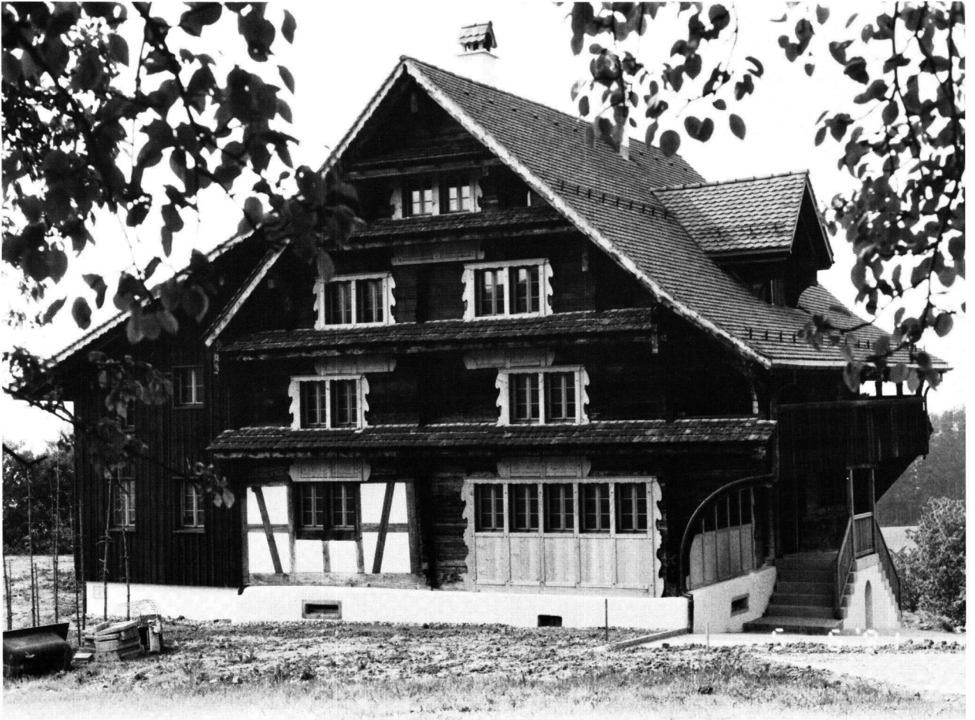
Abbildung 42 Feusisberg, ehemaliges Bürgerheim. Die Rückfront mit den anhand des Befundes rekonstruierten Ziehläden mit Seitenbärten.
