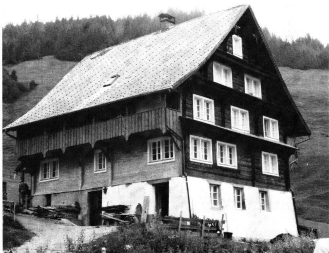
Abbildung 24 Unteriberg, Bauernhaus Meierhöfli. Die Hautfront nach der Restaurierung.
