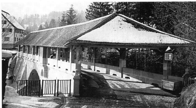
Abb. 22: «Tüüfelsbrugg» am Etzel.
