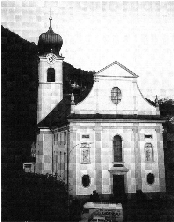
Abb. 2: Die Pfarrkirche von Westen.
