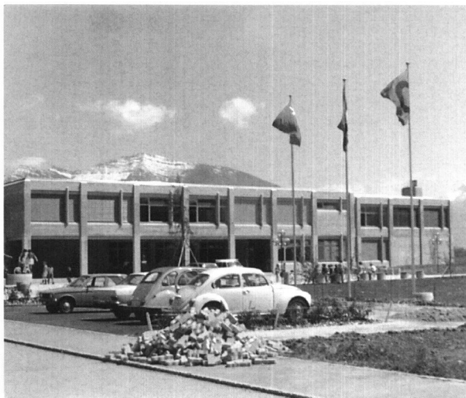
Abb. 8: Schulhaus Eneda kurz nach der Eröffnung im Frühling 1976.
