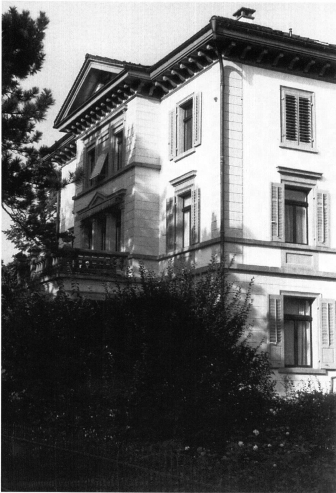
Abb. 9: Ingenbohl, Haus Eberle, Bahnhofstrasse, Brunnen. Die Villa gehört zu den qualitativsten Gebäuden des Spätklassizismus im Kanton Schwyz.
