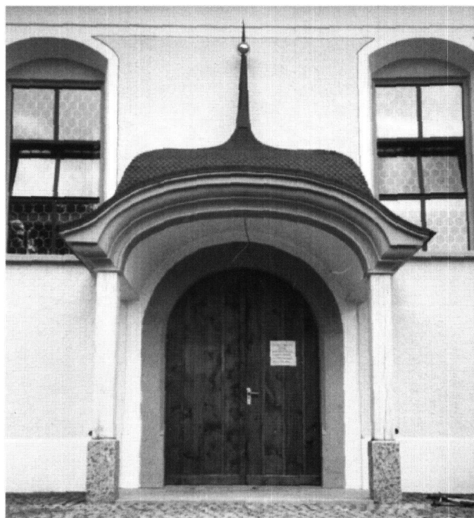
Abb. 1: Schwyz, Klösterli St. Josef im Loo. Für die Wiederherstellung der Farbigkeit und des Vorzeichens diente eine kolorierte Zeichnung des Schwyzer Kleinmeisters David Alois Schmid.
