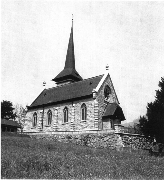
Abb. 6: Arth, reformierte Kirche Oberarth. Die Sandsteinfassaden nach der Sanierung. Wiederhergestellt sind die Firstabdeckungen aus Granit mit aufgesetzten Kreuzblumen.
