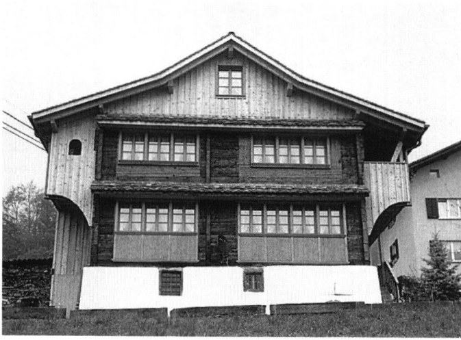
Abb. 5: Schwyz, Haus Büeler, Kaltbach. Nach der Restaurierung präsentiert sich das exponiert stehende Bauernhaus mit wiederhergestellten Lauben und Reihenfenstern mit Ziehläden.
