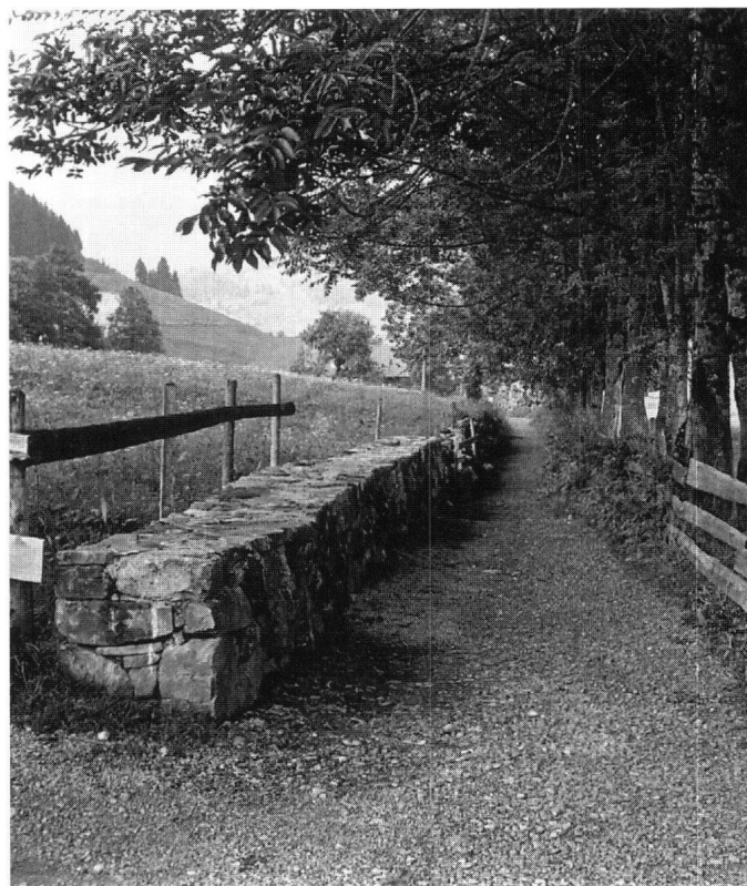
Abb. 14: Unteriberg, Gasse in der Schmalzgruben. Ein Teil der rund 500 Meter langen Gasse. Das abgebildete Wegstück wird lediglich auf der Bergseite von einer Stützmauer abgegrenzt.
