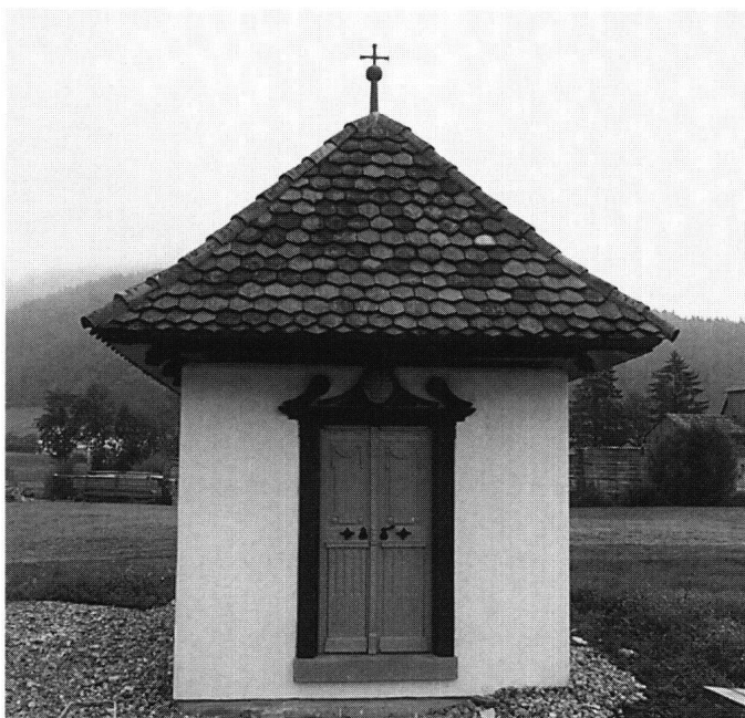
Abb. 20: Einsiedeln, Rütikapelle, Trachslau. Am Äussern der Kapelle dominiert das reich geschnitzte, rot gefasste Portal.
