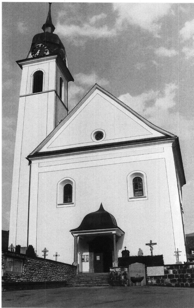
Abb. 11: Muotathal, Pfarrkirche St. Sigmund und Waldburga. Die Hauptfassade nach der Wiederherstellung der aufgemalten architektonischen Gliederung.
