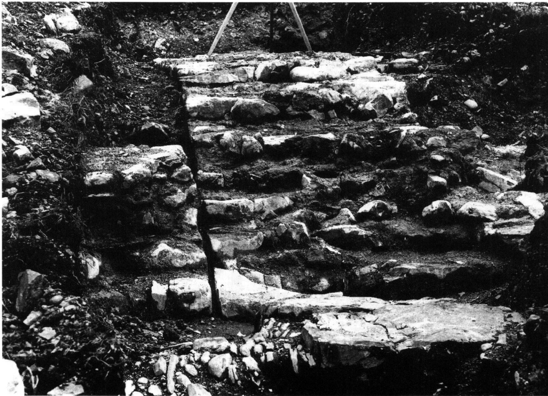
Abb. 5: Nordostecke des Kernbaus mit Anstoss der Südwand der Schiffserweiterung gegen Norden.
