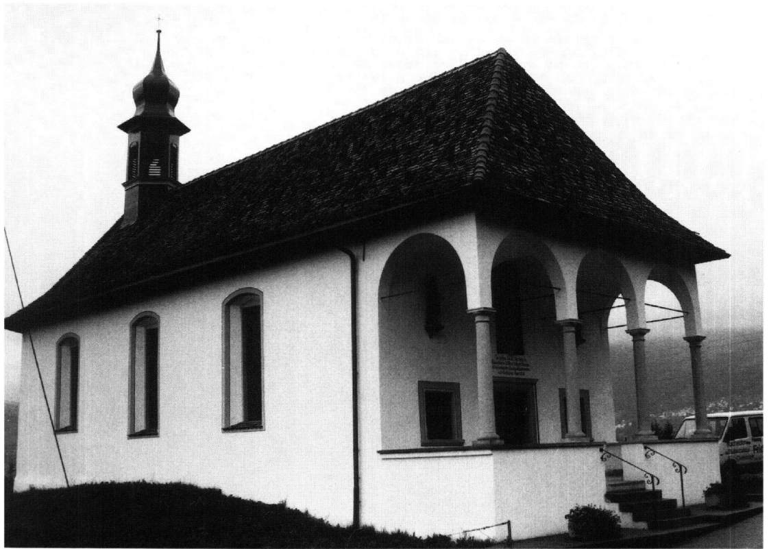
Abb. 9: Ingenbohl, Kapelle St. Wendelin, Unterschönenbuch. Das Äussere der Kapelle zeigt das Erscheinungsbild der Errichtung im Jahr 1709. Die Farbigkeit wurde anhand des Befundes wiederhergestellt.
