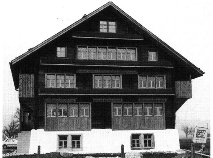
Abb. 21: Schübelbach, Haus Ziegler. Die Fassaden des 1596 erbauten Hauses wurden im 18. Jahrhundert verändert. Die zu diesem Zeitpunkt vergrösserten Fenster und die vorgehängten Klebdächer wurden in das Restaurierungskonzept miteinbezogen.
