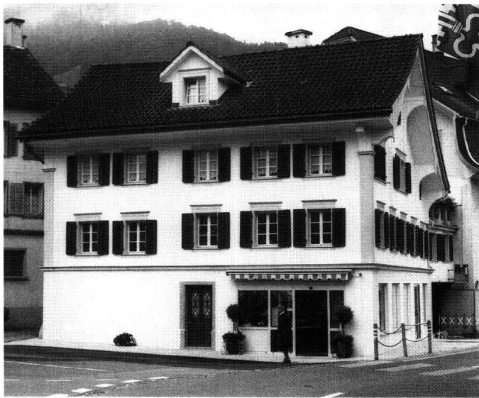
Abb. 14: Steinen, Krone. Die Krone besitzt am Dorfplatz von Steinen einen sehr hohen Stellenwert. Die platz- und strassenseitigen Fassaden wurden um die Mitte des 19. Jahrhunderts im Stil der Zeit verändert.
