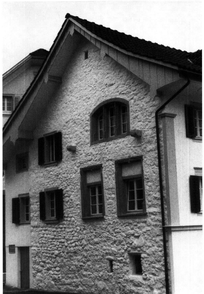
Abb. 15: Steinen, Krone. Auf der Nordseite der Krone konnte der ehemalige Turm mit den jüngeren Fenstern des 15. Jahrhunderts sichtbar gemacht werden, ohne die Einheit des Gebäudes zu stören.
