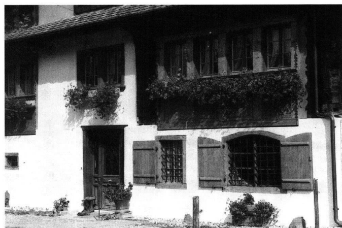
Abb. 25: Schübelbach, Haus Dobler. Die grossen Fensteröffnungen im Erdgeschoss lassen vermuten, dass im Erdgeschoss nicht nur Kellerräume untergebracht waren.
