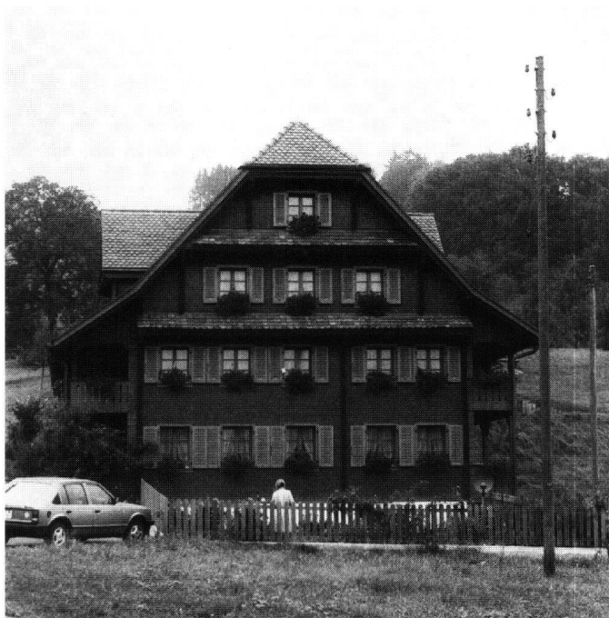
Abb. 26: Küssnacht, Haus Zelgerhöfli, Haltikon. Der Umbau des 19. Jahrhunderts hat das wesentlich ältere Gebäude stark, aber in traditioneller Art verändert. Dieser Zustand wurde bei der Restaurierung beibehalten.
