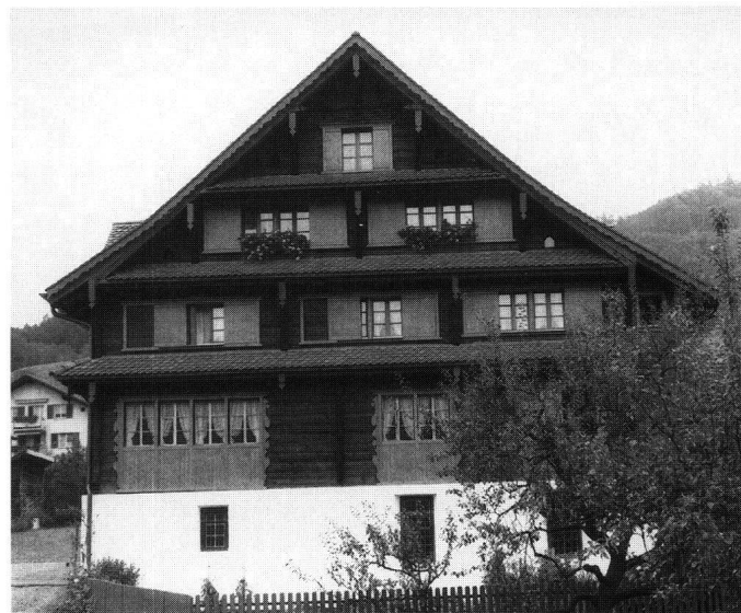
Abb. 16: Steinen, Haus Reichlin. Die Fassaden des Bauernhauses Reichlin haben die Zeit ohne eingreifende Veränderungen überdauert. Die Restaurierung hatte somit zum Ziel, die überlieferte Substanz zu pflegen und zu ergänzen.
