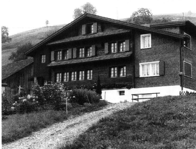
Abb. 11: Ingenbohl, Haus Lüönd/Schibig, Unterschönenbuch. Zur besseren Präsentation der Hauptfront wurde der Anbau des 19. Jahrhunderts in seiner Grösse reduziert und formal vom Altbau abgesetzt.
