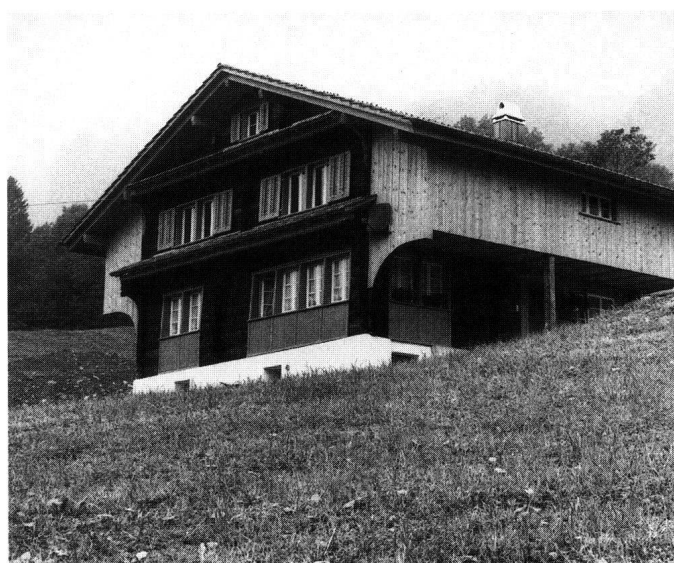
Abb. 13: Muotathal, Haus Gigeren. An landschaftlich exponierter Lage steht das vermutlich in der ersten Hälfte des 19. Jahrhunderts erbaute Bauernhaus. Da dekorative Details fehlen, ist eine genaue Datierung innerhalb des konservativen bäuerlichen Baubestandes oft schwierig.
